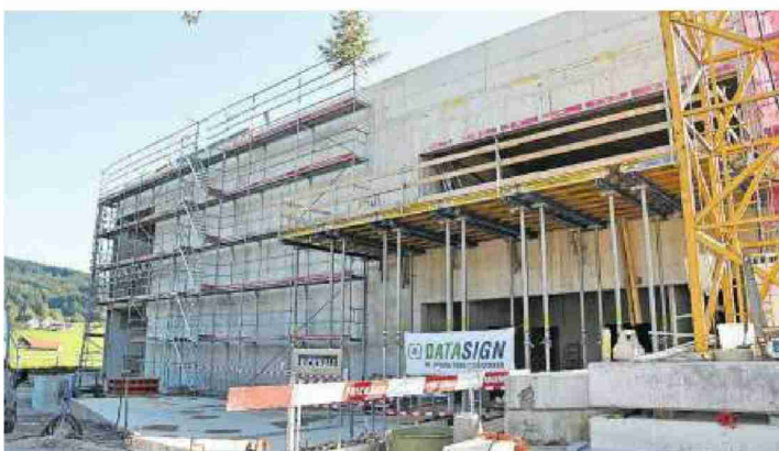
Der Rohbau des Rechenzentrums in Gais ist abgeschlossen. Bild: gia
