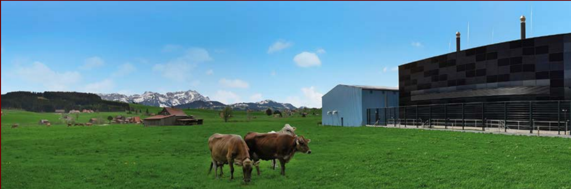
Hochsicherer Datentresor: Der futuristische Cube des Rechenzentrums Ostschweiz mitten im Appenzellerland ist gleichzeitig auch ein riesiges Solar- und Wärmekraftwerk für die Region.
